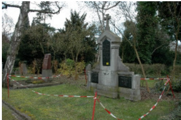
Verlassene Grabstätte – aus Gründen der Standsicherheit abgesperrt. Da bleibt noch viel zu tun
